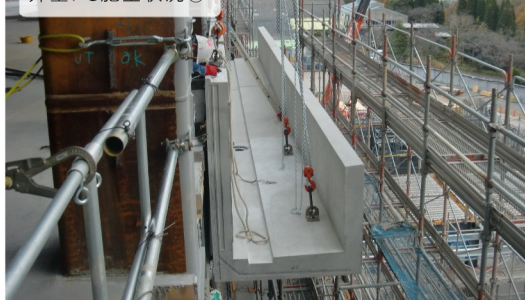
外壁PC施工状況②
