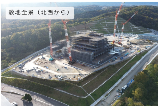
鉄骨建て方施工状況
