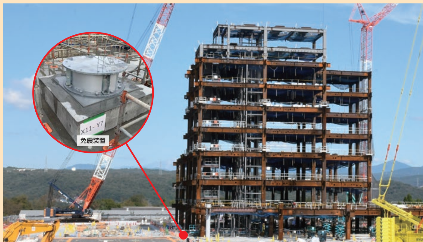
新病院本棟の鉄骨建て方工事中です。建物全体の約1/4の鉄骨の組み立てが終わりました。(令和6年10月時点)
