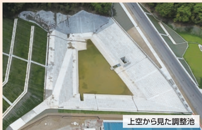
南東側から見た建設地（令和6年10月末日）
